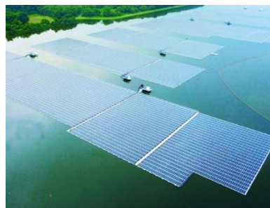
Slika 6. Plutajuća fotonaponska solarna elektrana u Singapuru [10]
