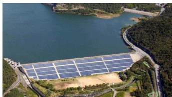
Slika 5. Solarni fotonaponski paneli na akumulaciji brane Gangen, Japan [9]
